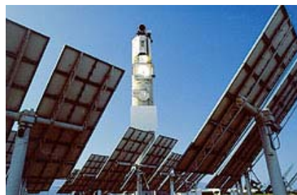
Solarturmkraftwerk: Sechs Stunden Sonne reichen für die Versorgung der Welt
